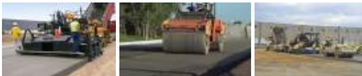
Şekil 1. Beton yol için SSB uygulaması
