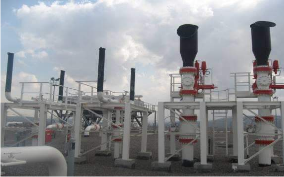
Şekil 7. Tahliye (Relief, Blowdown) Vanaları
